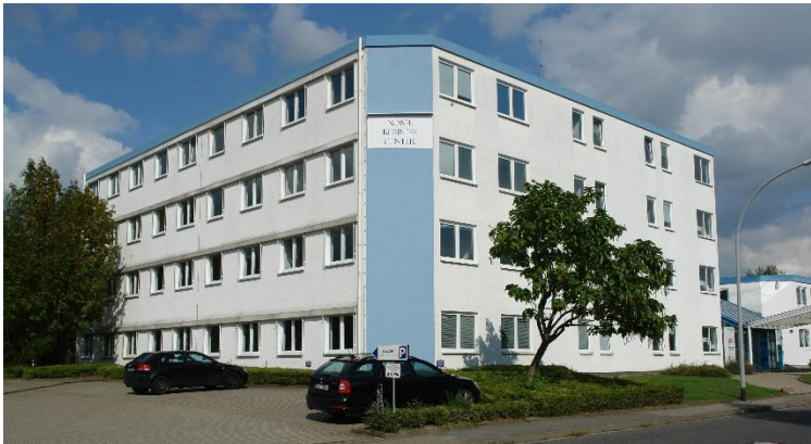
Gebäude von außen
